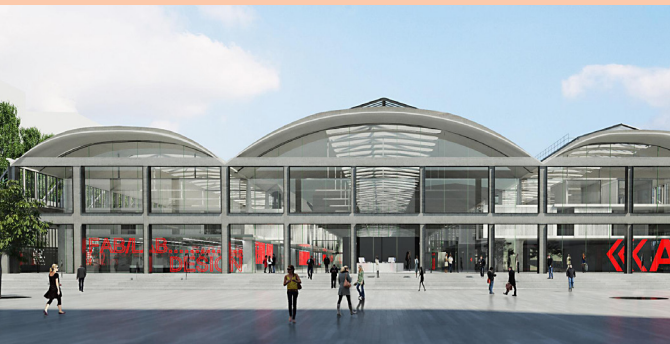
La Halle Freyssinet 2017© Wilmotte et Associés Architectes
